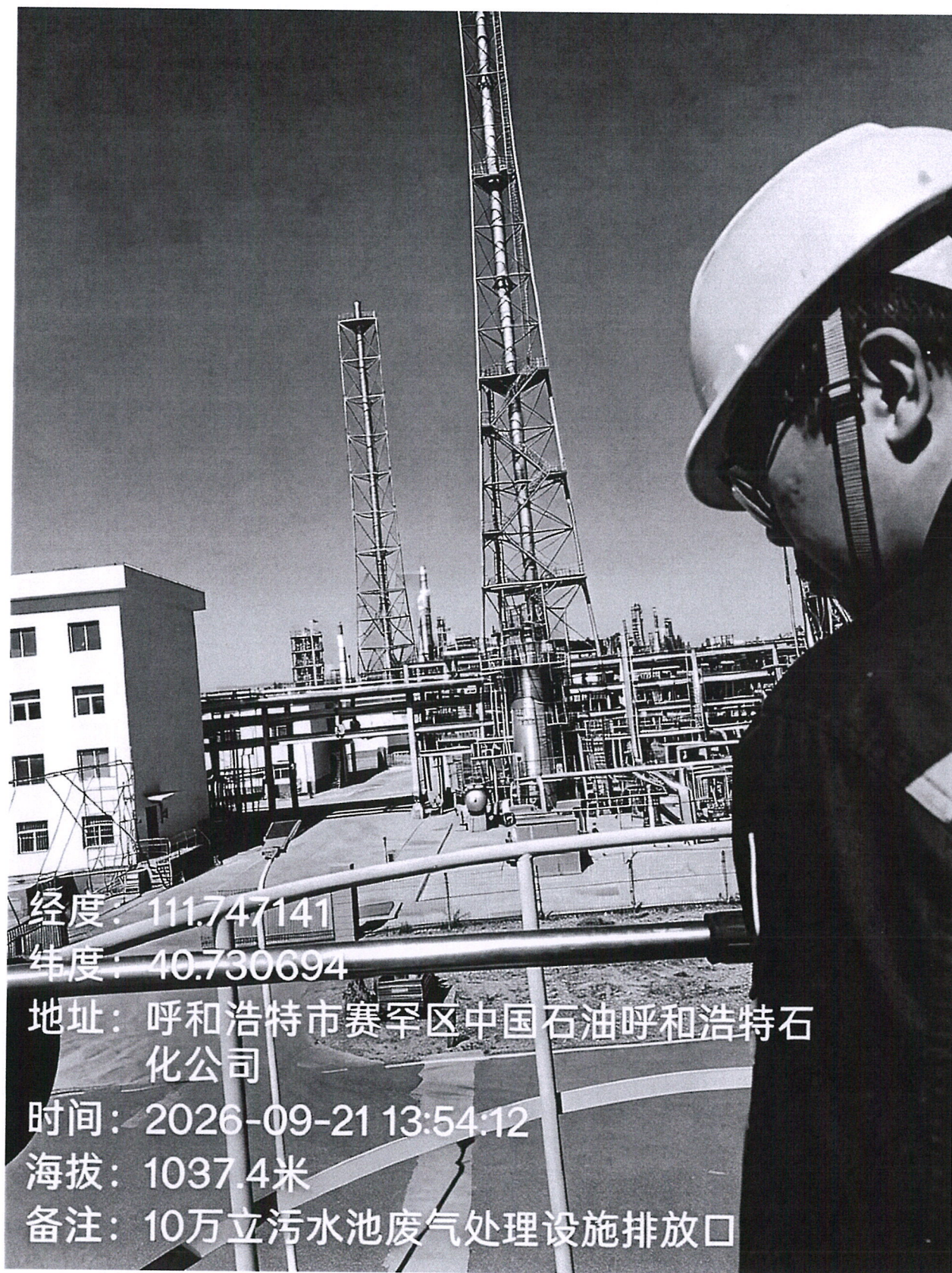
图 1 现场监测照片
