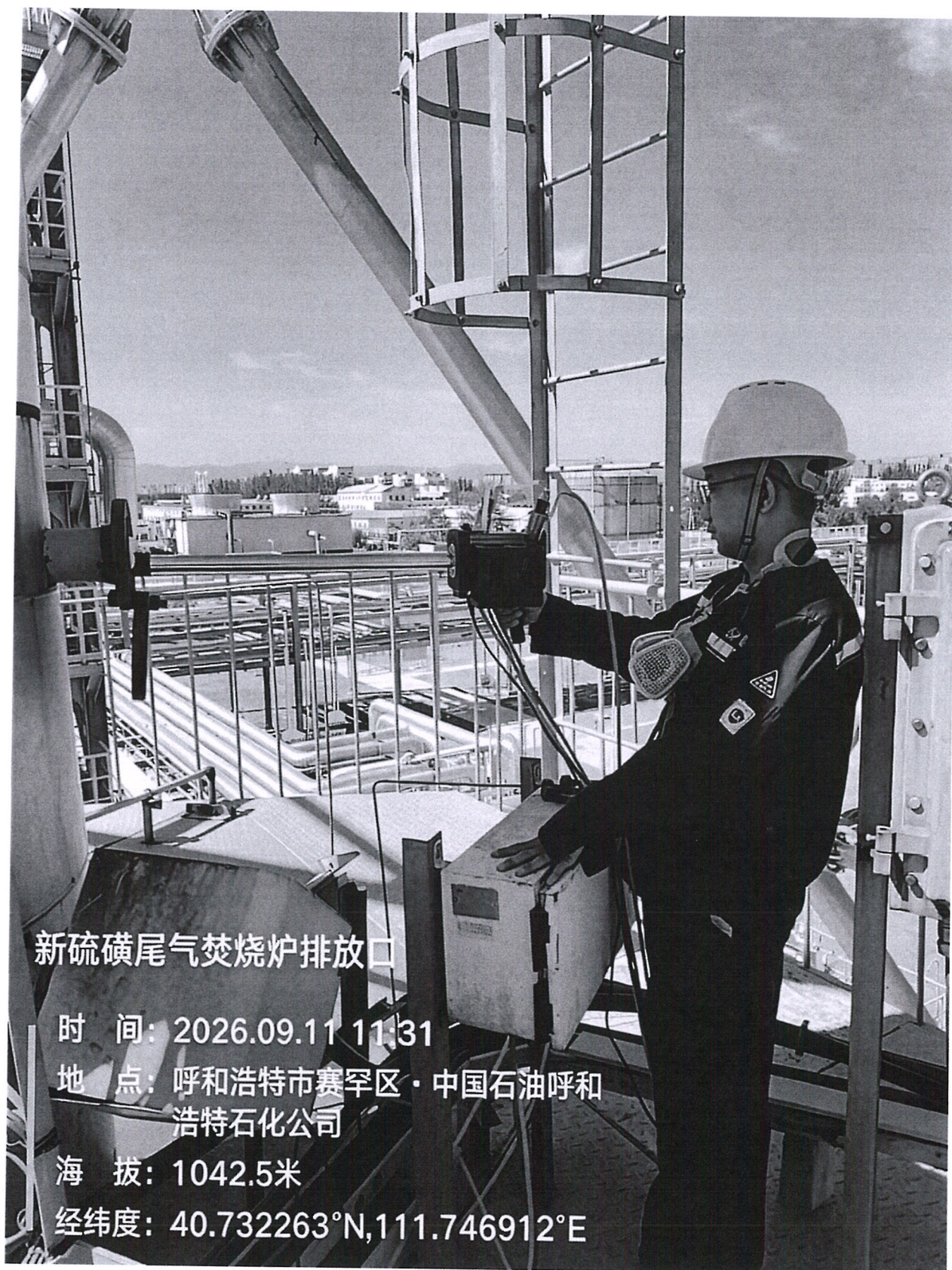
图 1 现场监测照片
