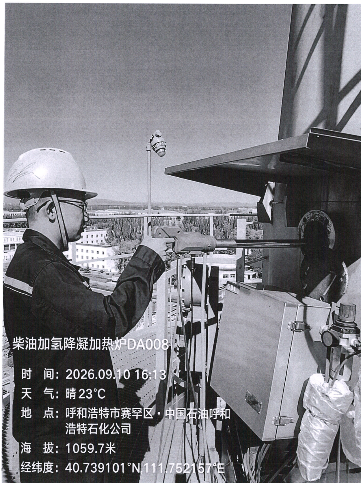
图 1 现场监测照片
