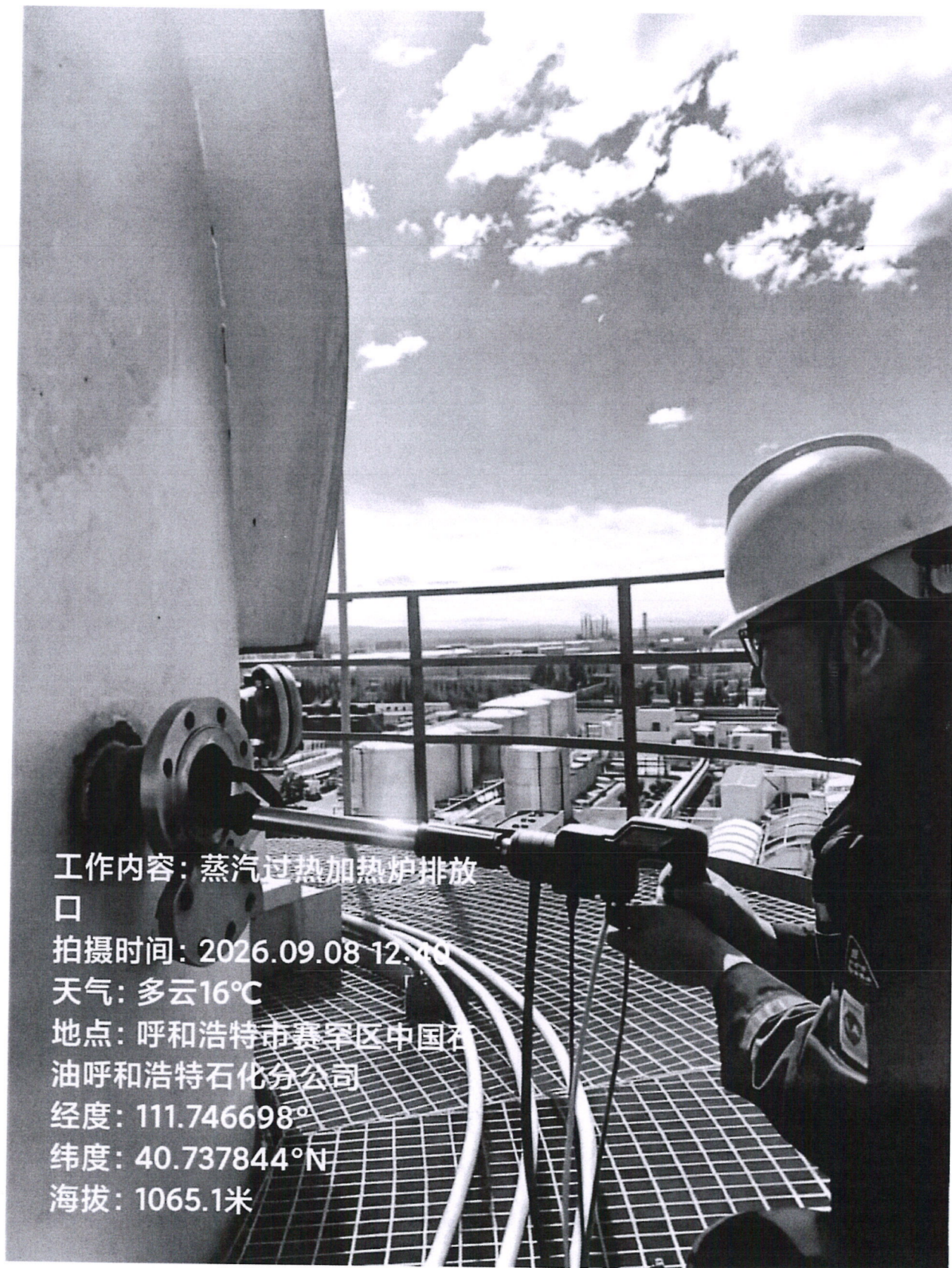
图 1 现场监测照片
