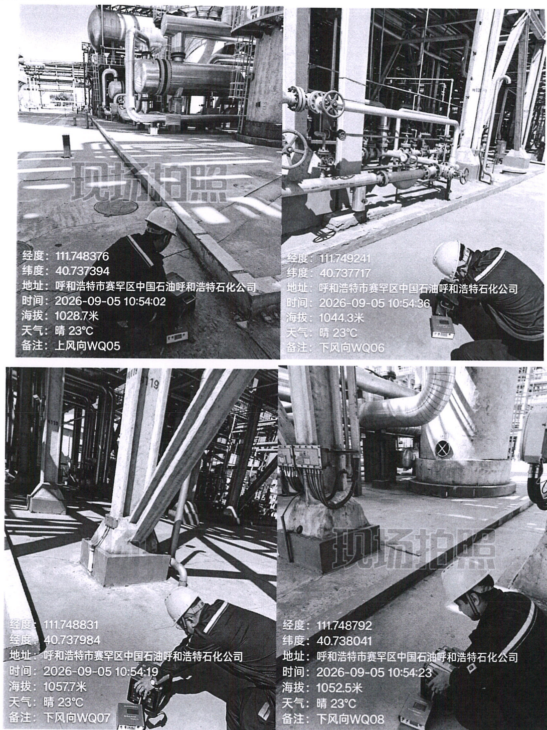
图 1 现场监测照片
