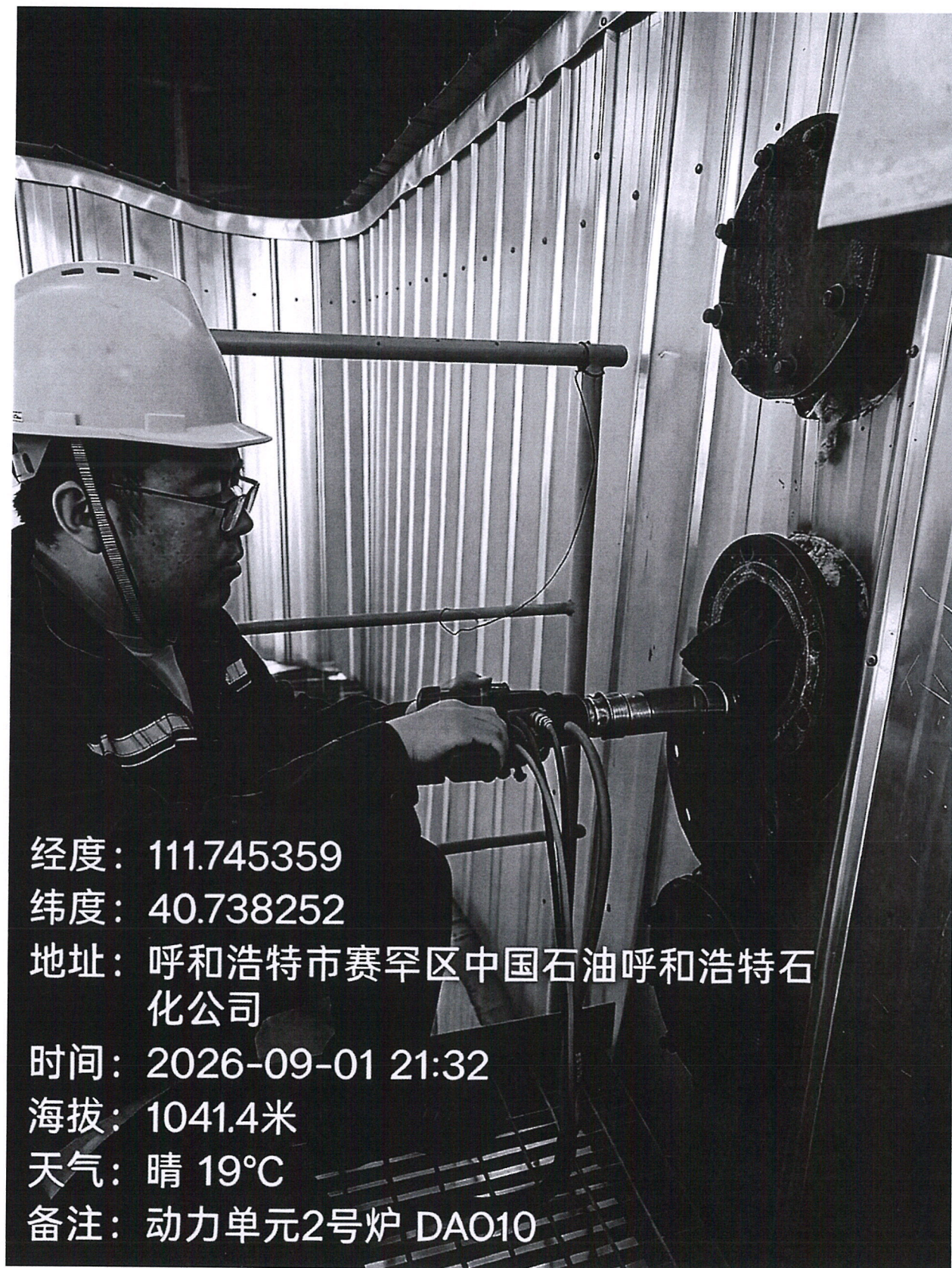
图 1 现场监测照片
