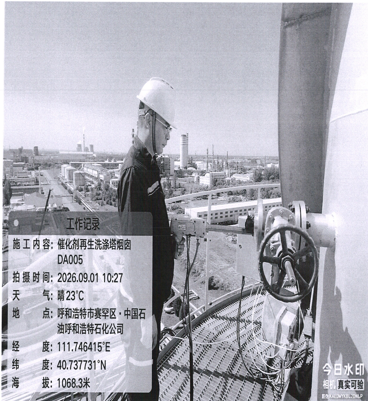
图 1 现场监测照片
