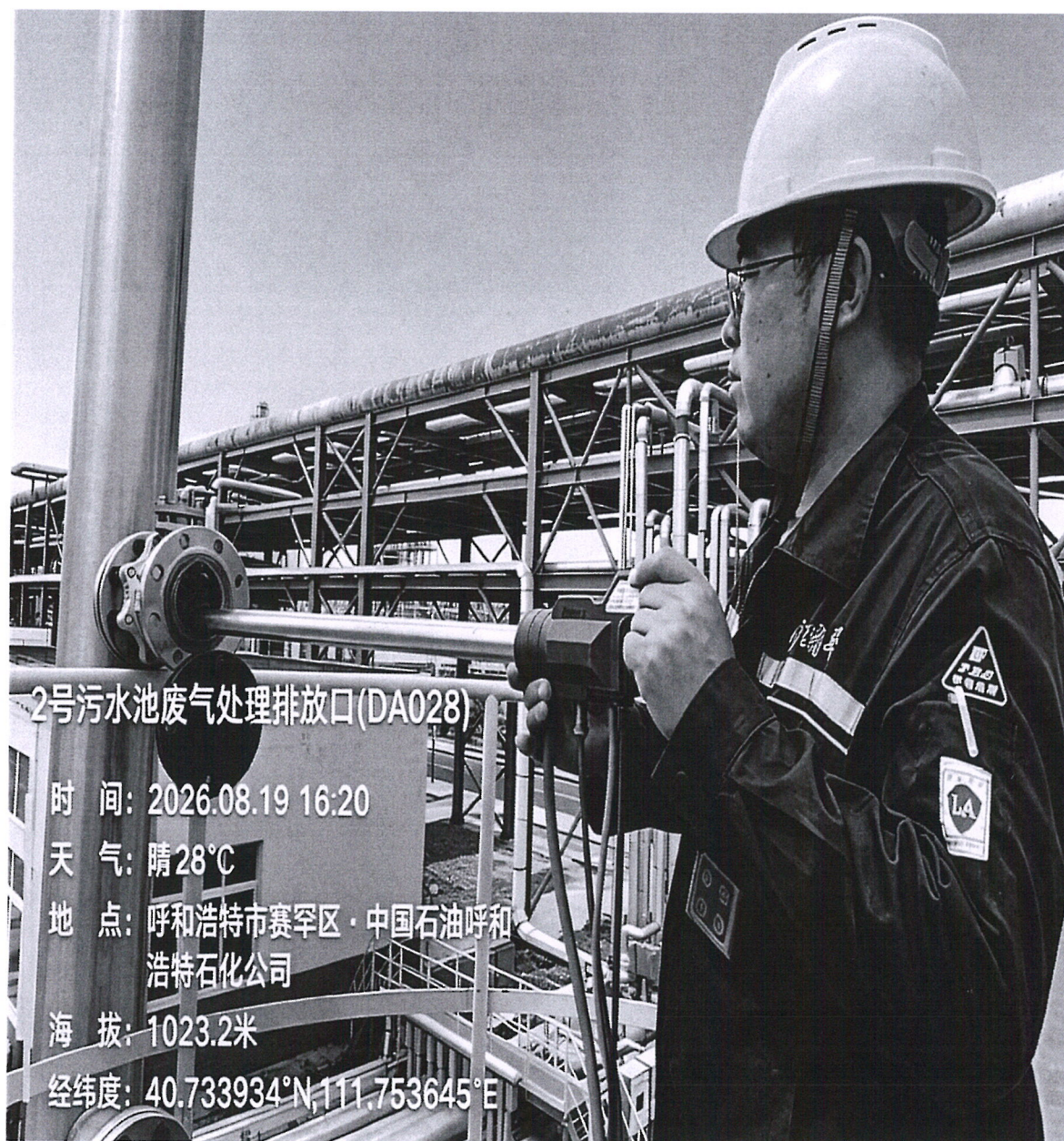
图 1 现场监测照片
