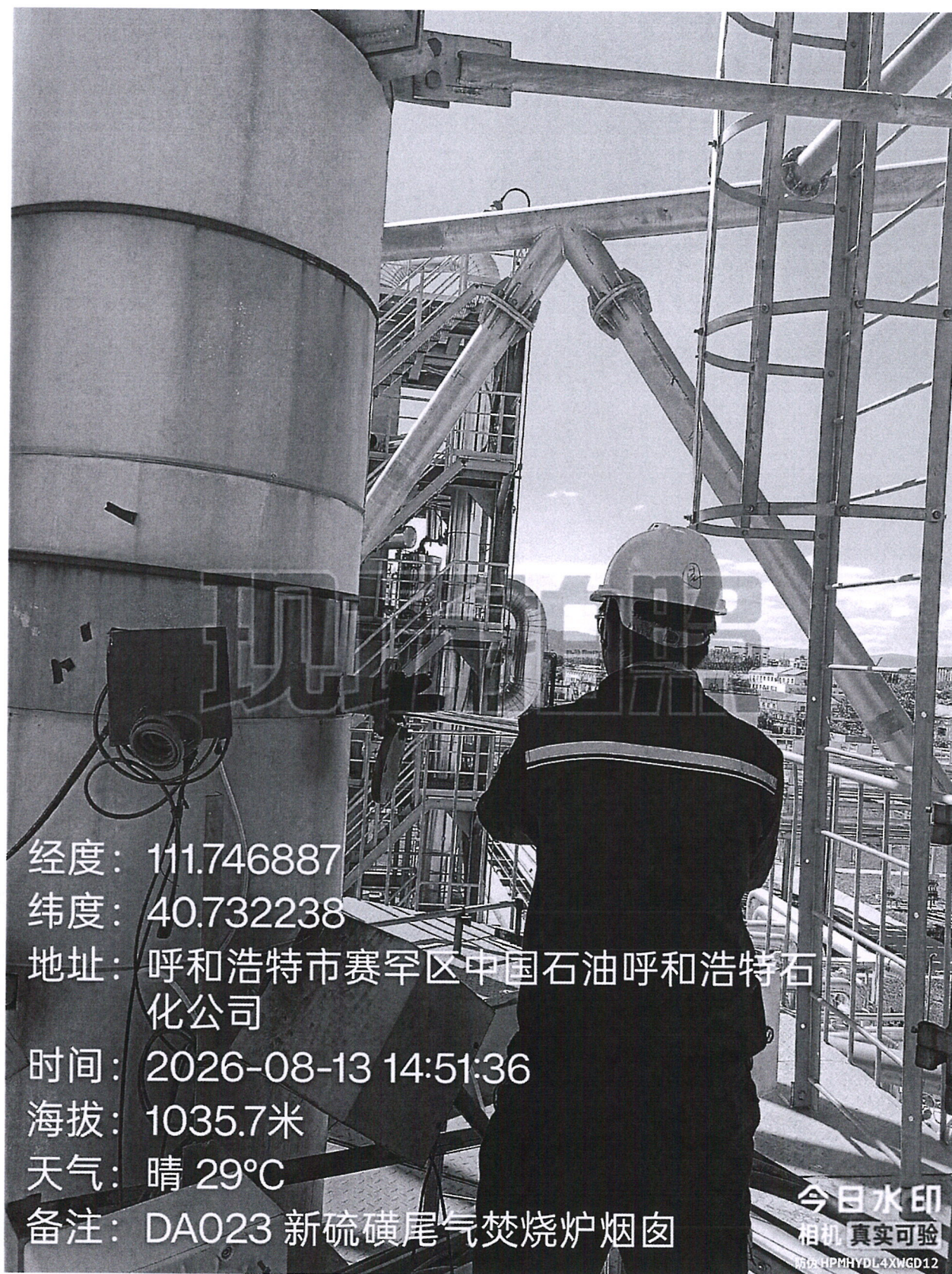
图 1 现场监测照片
