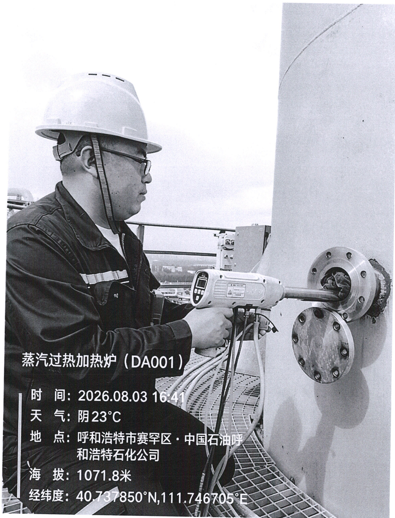
图 1 现场监测照片
