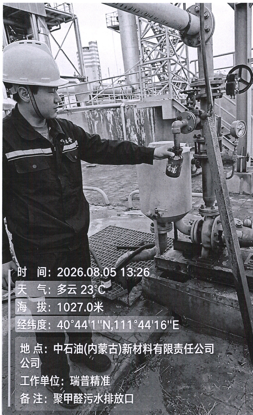
图 1 现场监测照片
