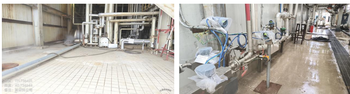
图3.2-1 现场踏勘照片
