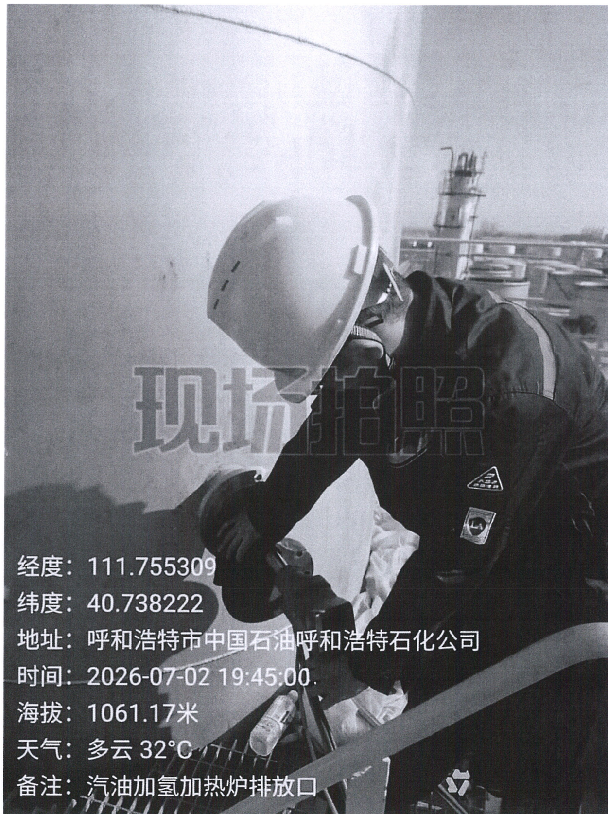
图 1 现场监测照片
