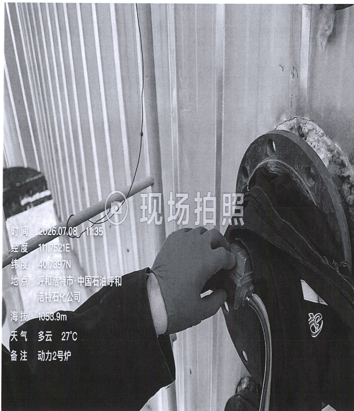
图 1 现场监测照片
