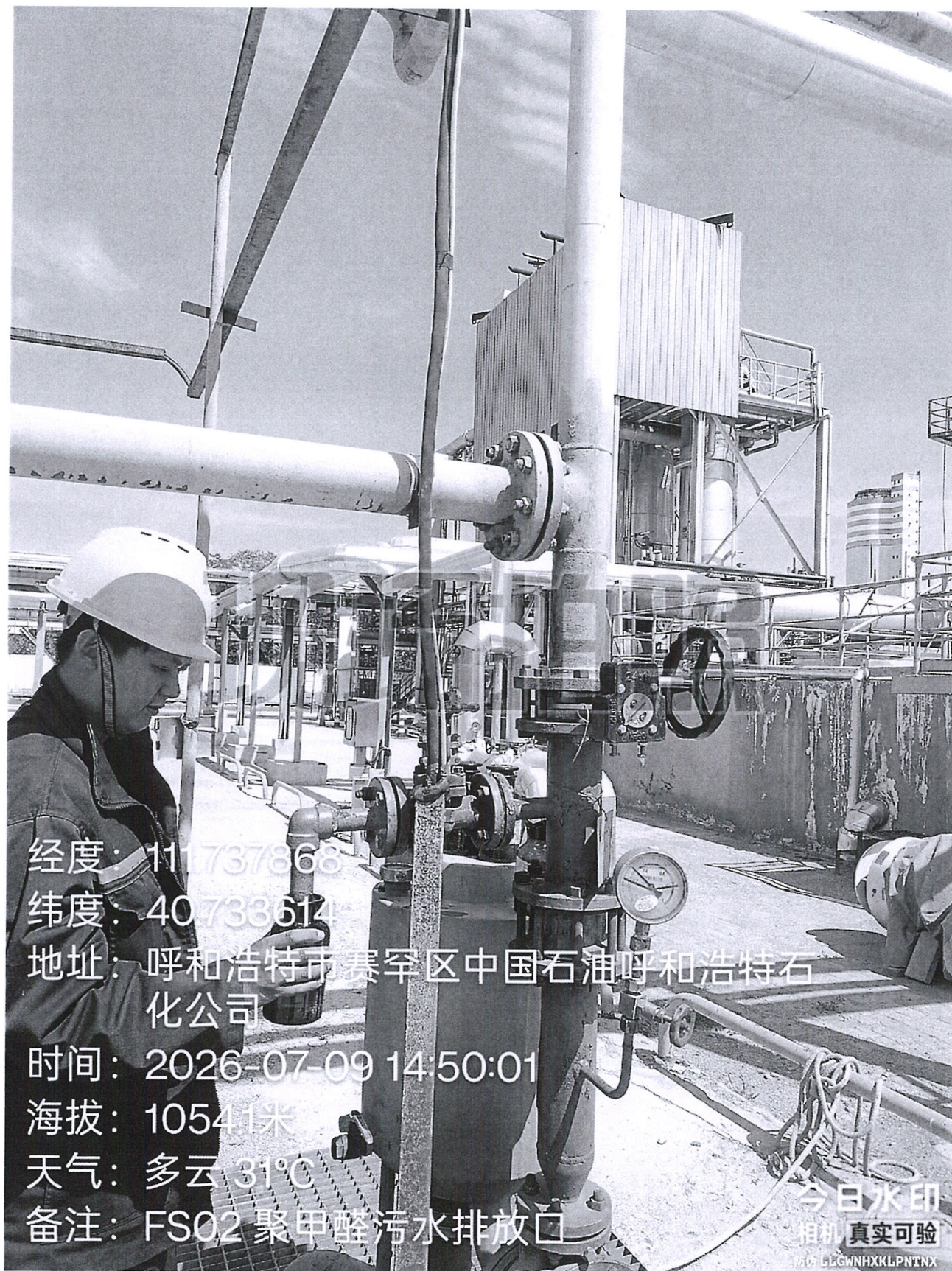
图 1 现场监测照片
