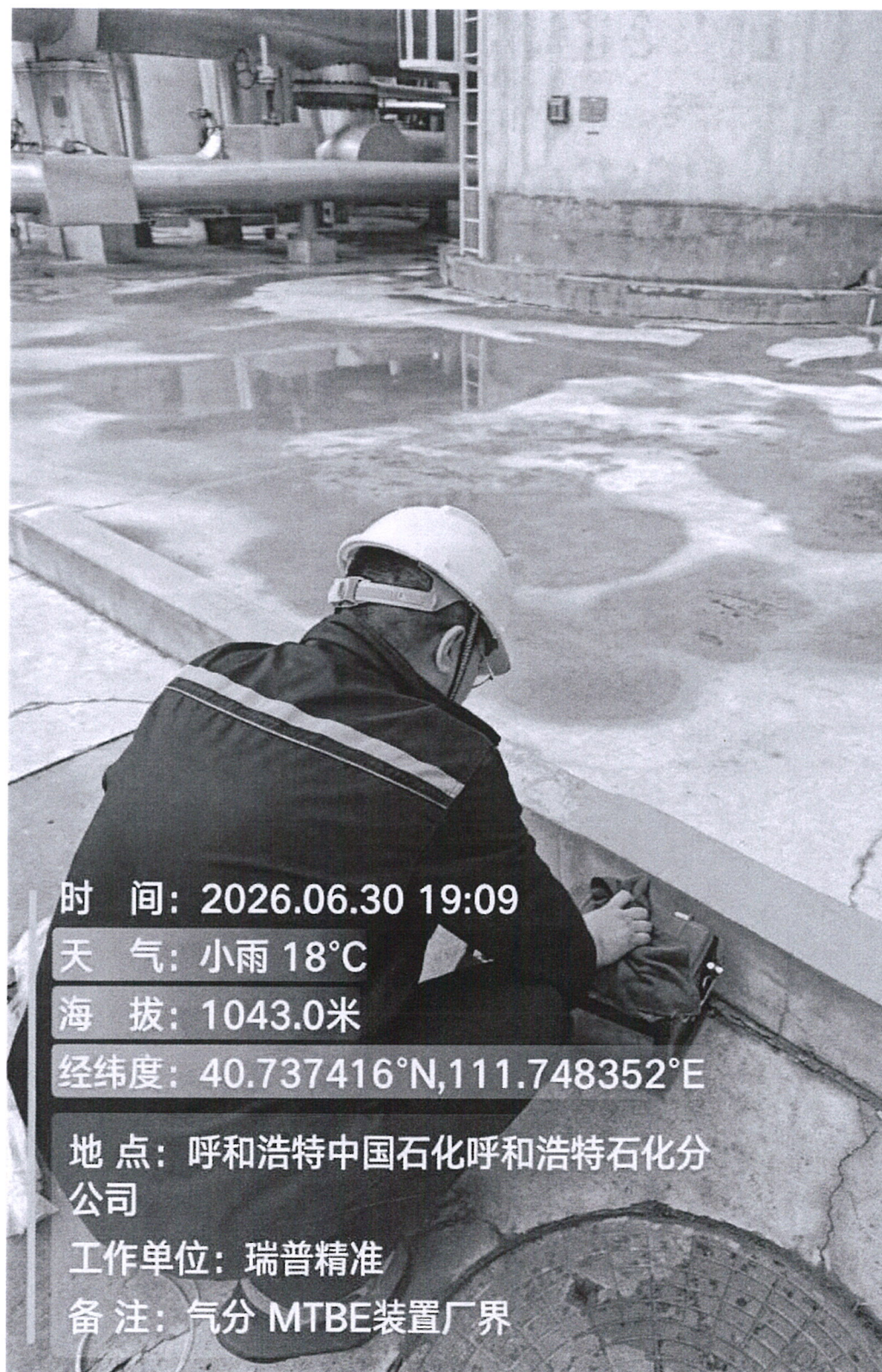
图 1 现场监测照片
