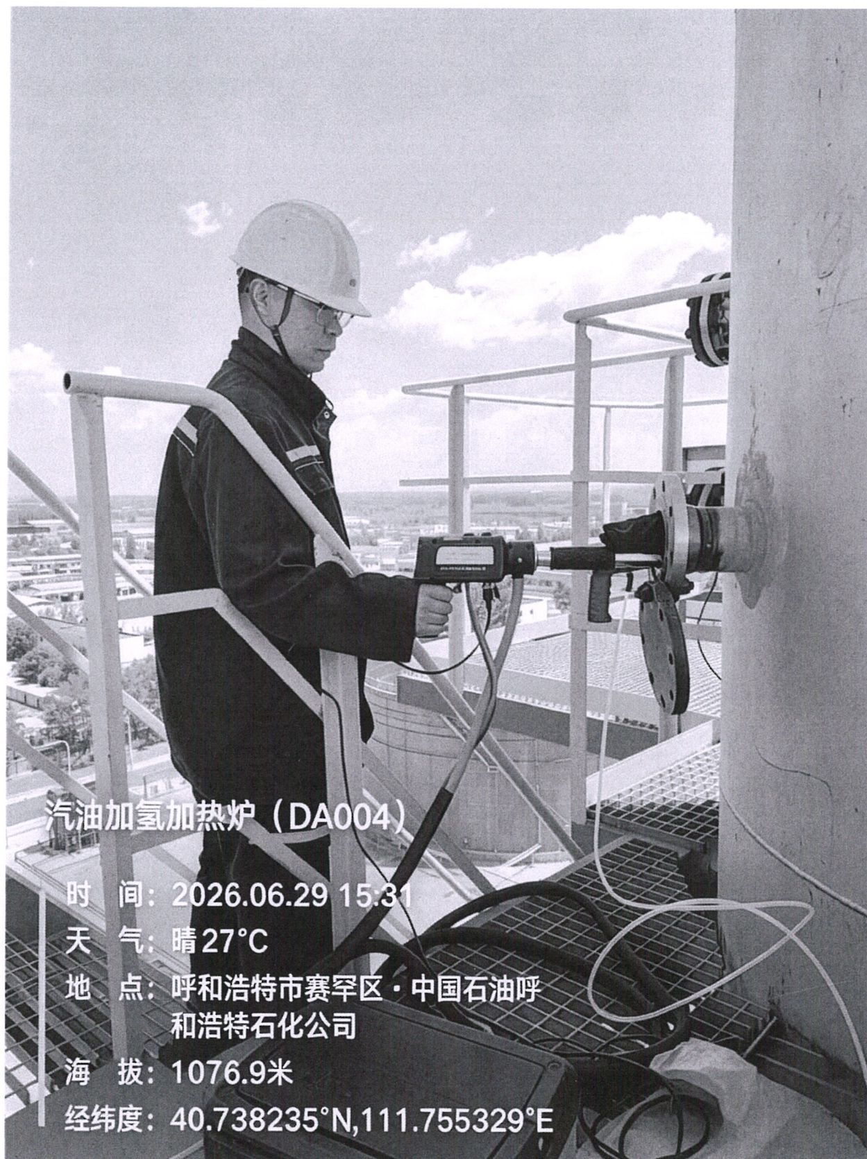
图 1 现场监测照片
