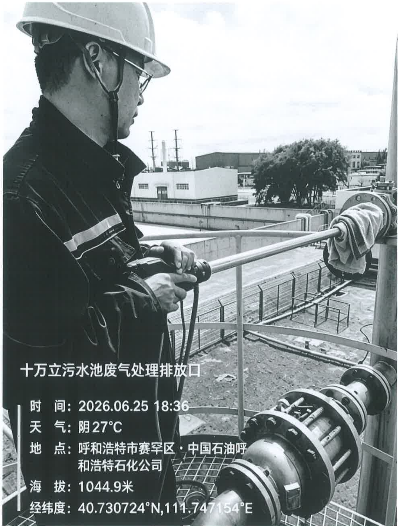
图 1 现场监测照片
