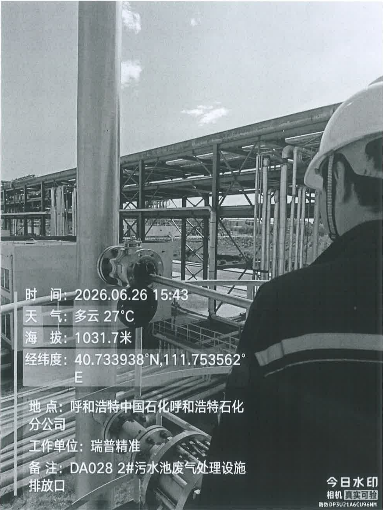
图 1 现场监测照片
