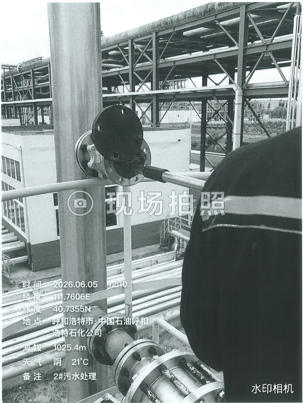
图 1 现场监测照片
