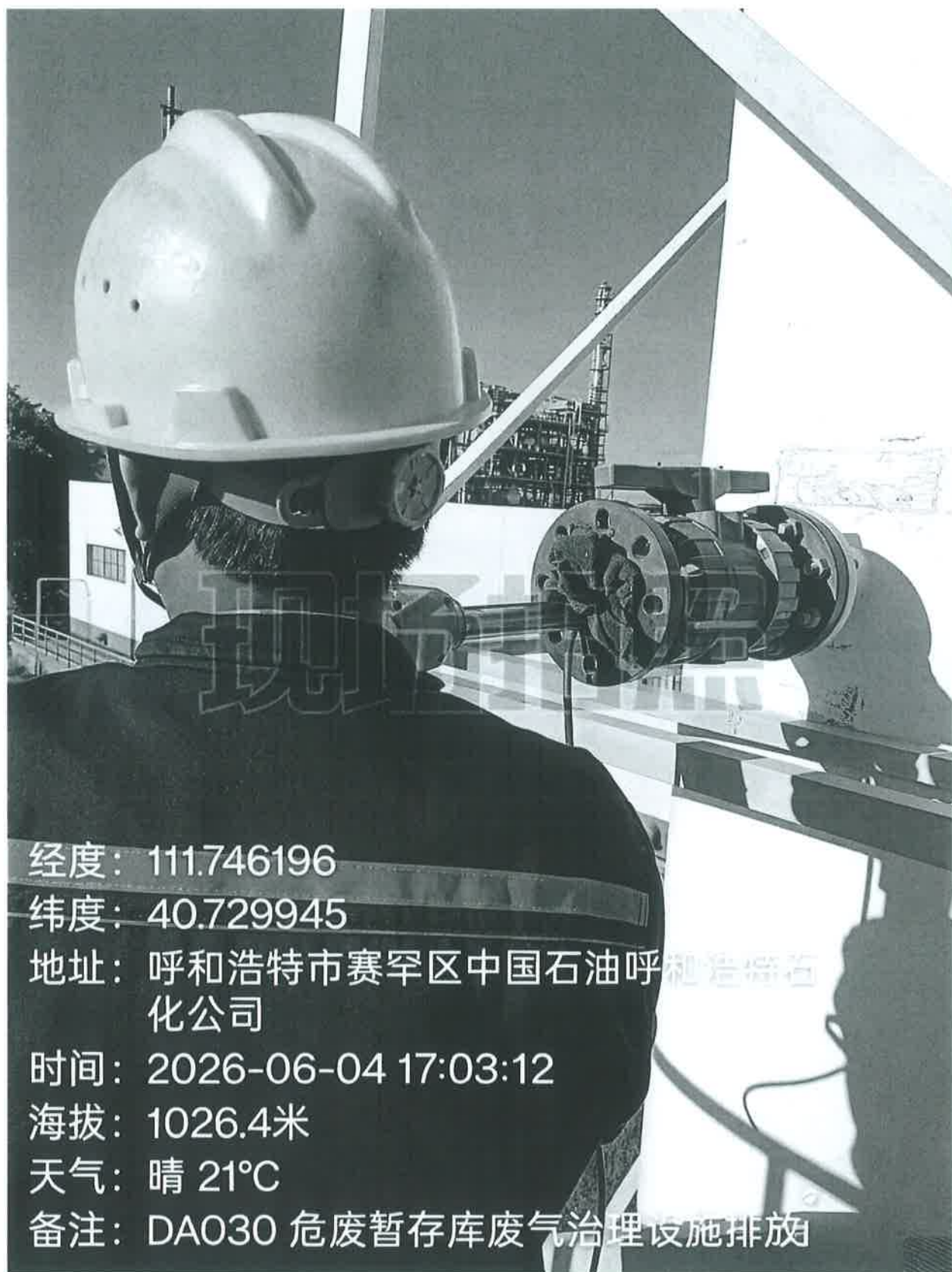
图 1 现场监测照片
