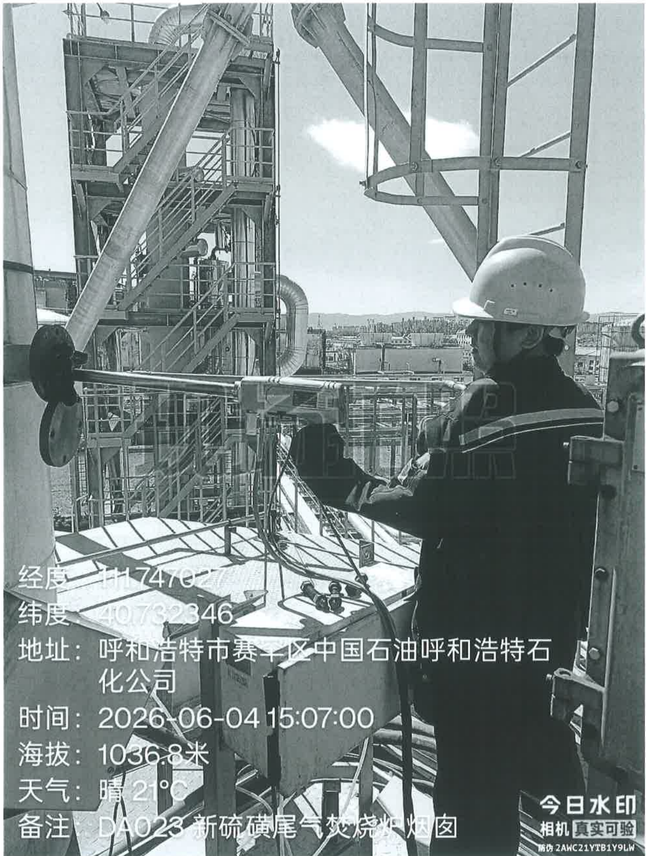
图 1 现场监测照片
