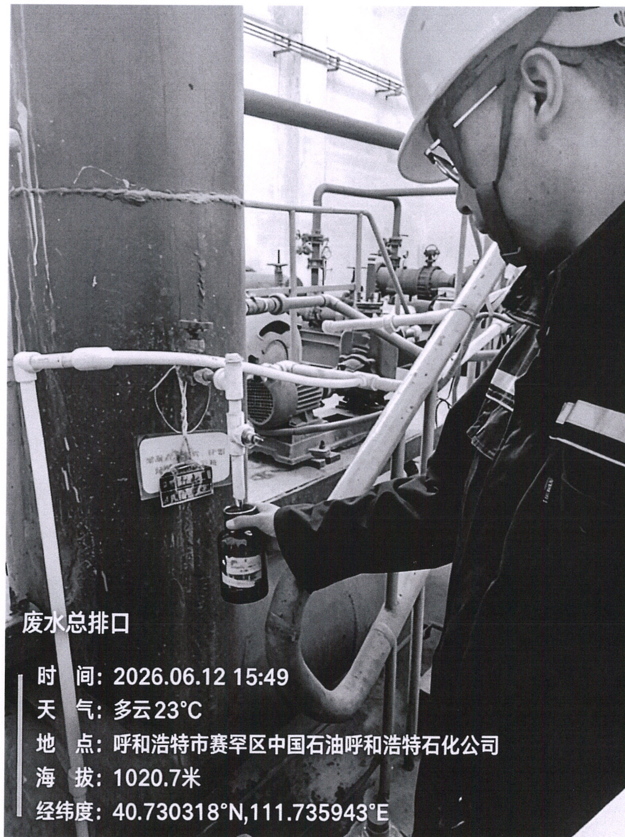
图 1 现场监测照片
