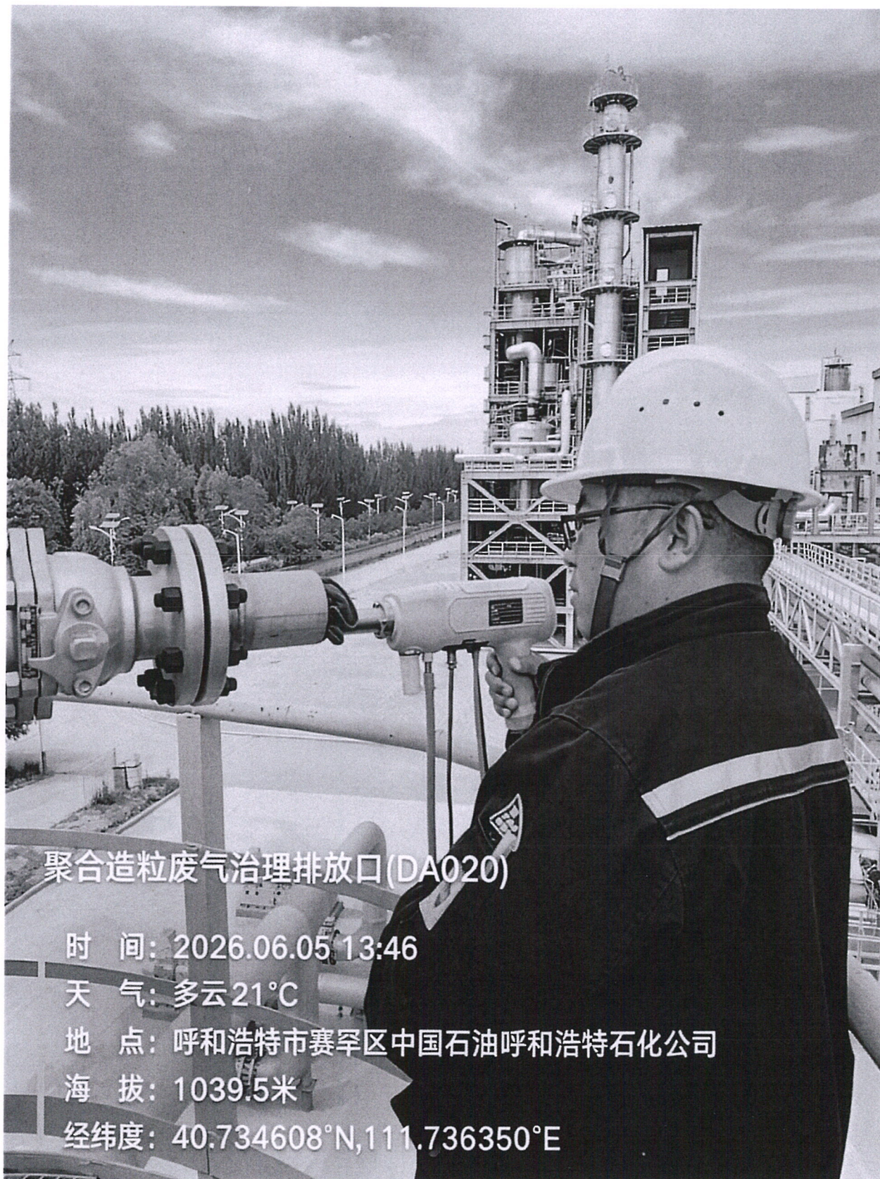
图 1 现场监测照片
