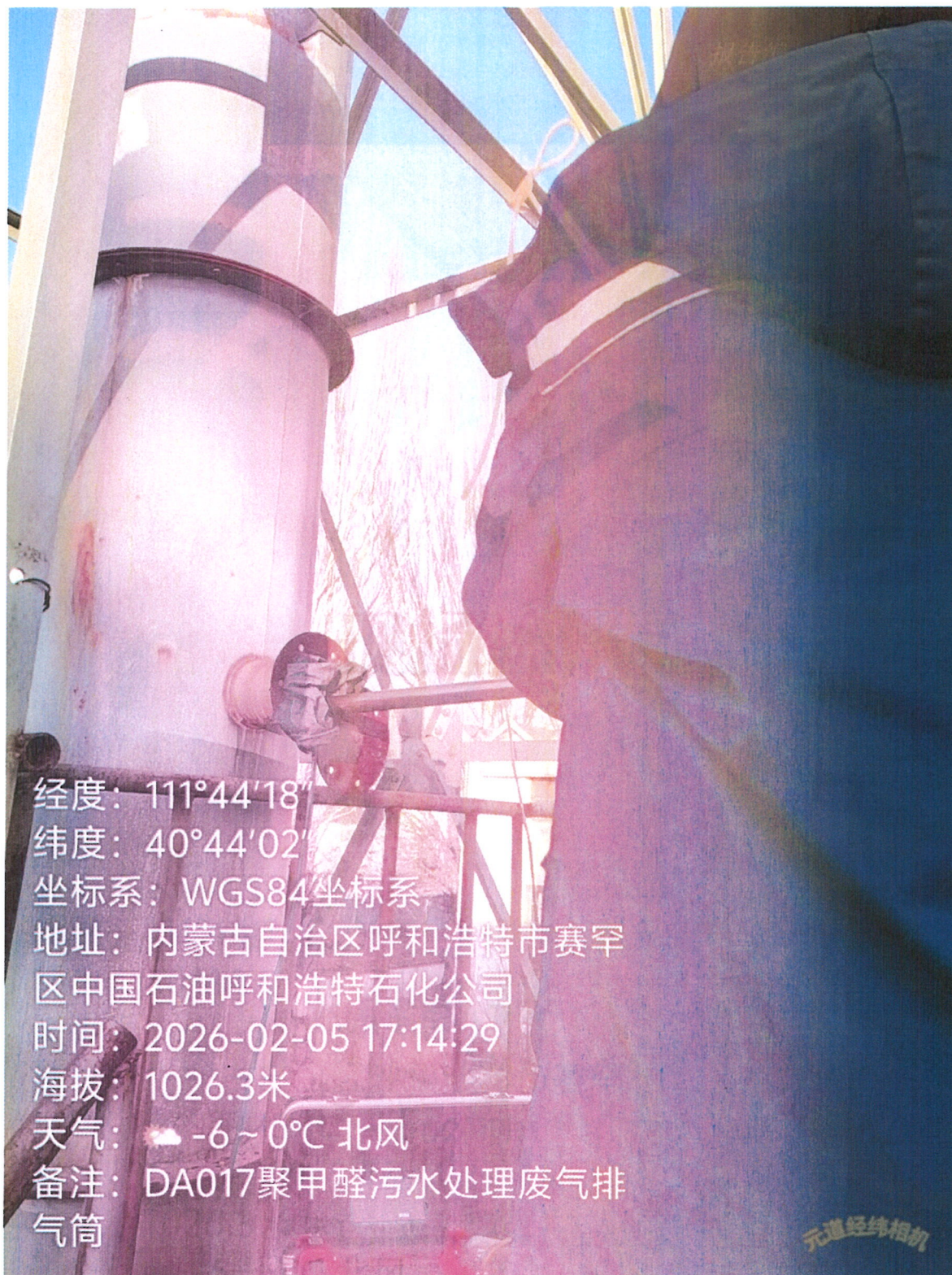
图1 聚甲醛污水处理排气口采样点位照片
