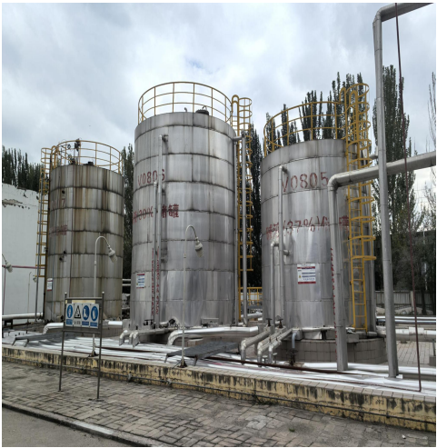
接地储罐及围堤
