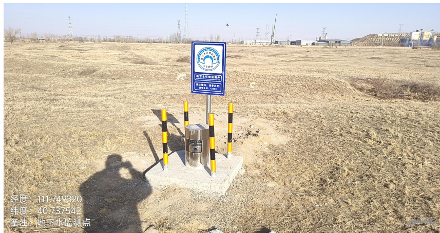
地下水监测井
