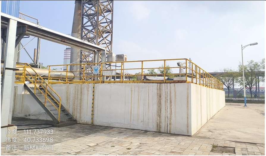
地下半地下池体
