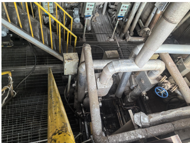
位于阻隔池内地下储罐
