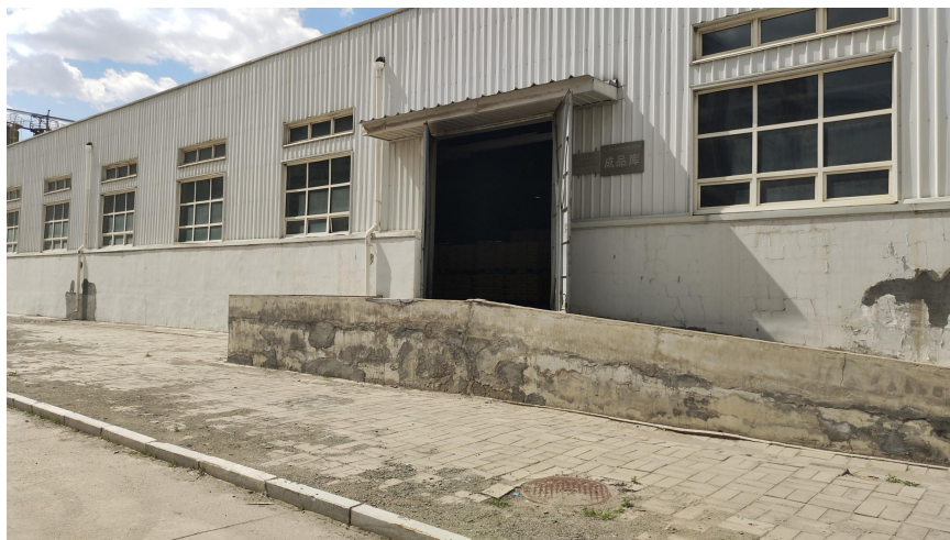
聚甲醛储存库房
