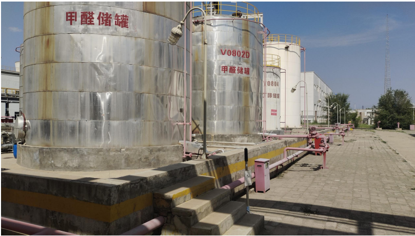
接地储罐及围堤
