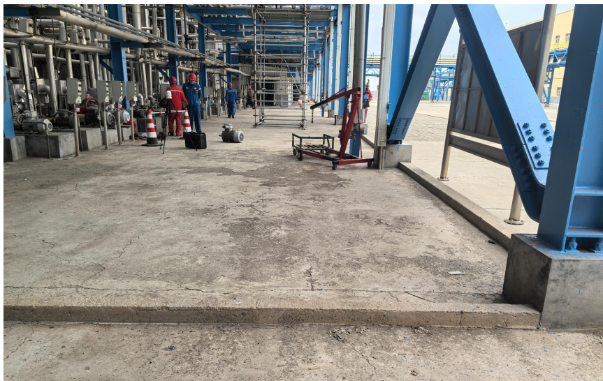
装置普通阻隔设施
