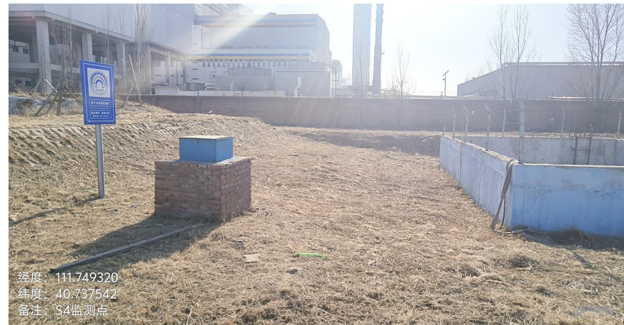
地下水监测井
