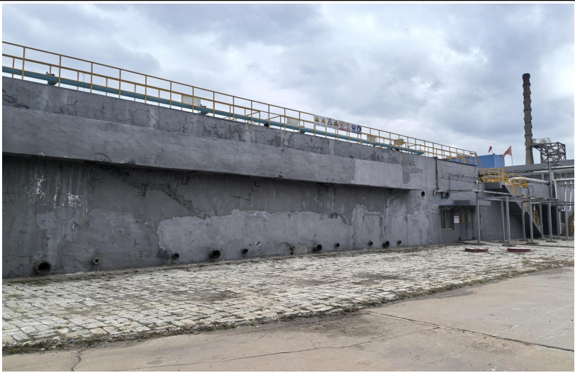
地下半地下池体
