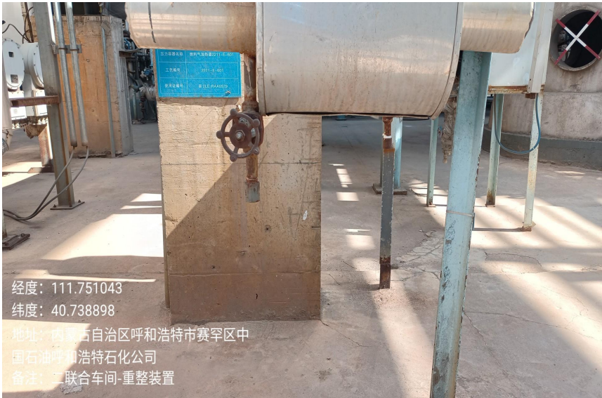
带封帽的导淋带封堵
