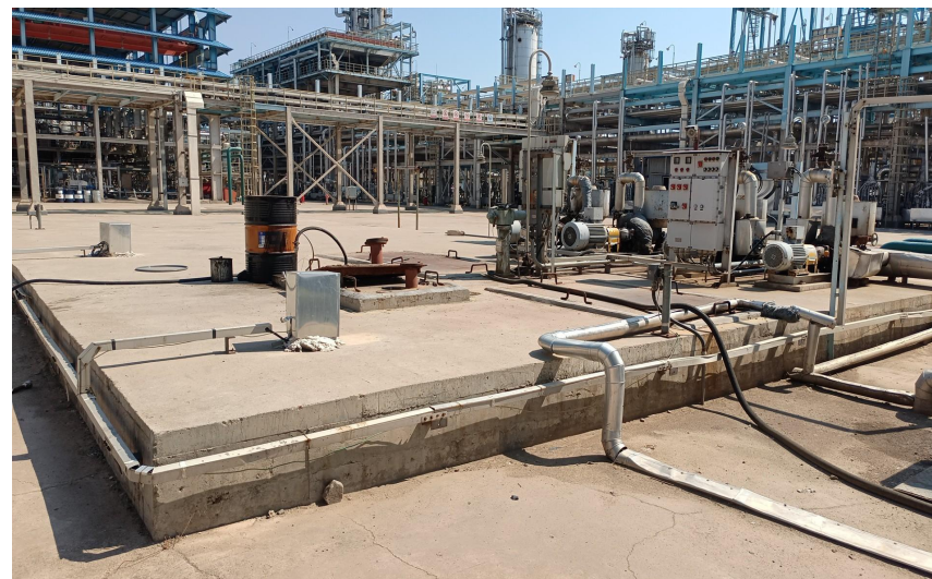
地下半地下池体池体完好
