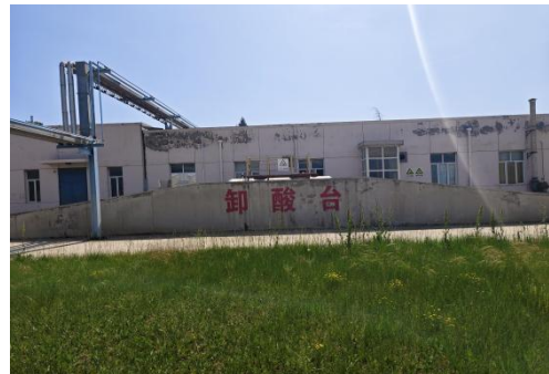
公用工程部 2#循环水场硫酸卸酸台
