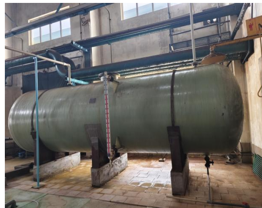
公用工程部玻璃钢酸罐 0713-V-107
