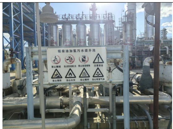
炼油二部煤柴油加氢精制隔油池
