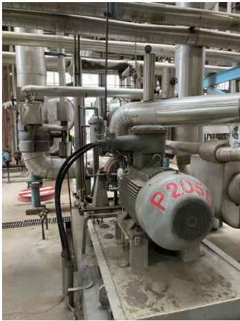
传输泵进料端控制阀门
