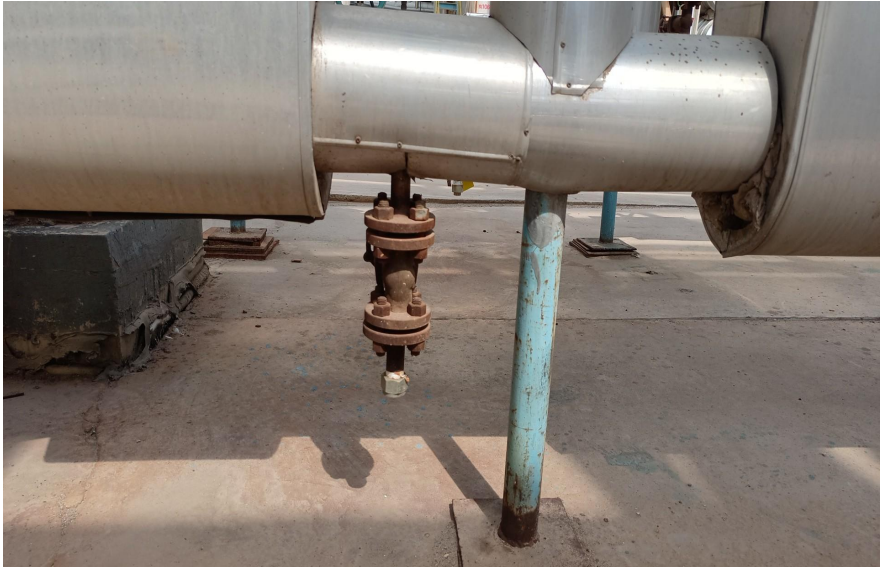
带封帽的导淋带封堵
