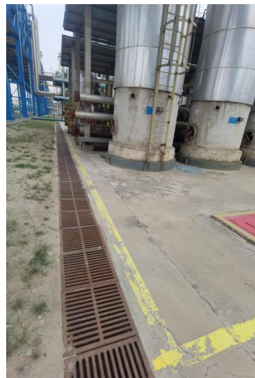
炼油二部氢提纯装置（1#PSA)排水沟
