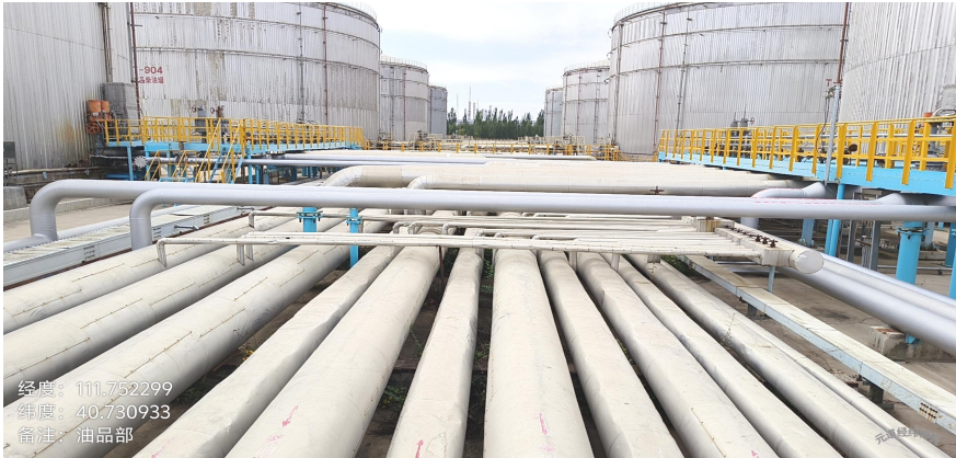
罐区内的地上管道无泄漏痕迹
