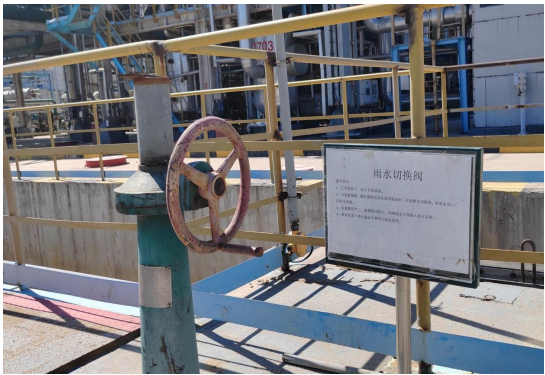
炼油三部聚丙烯污水池雨污切换
