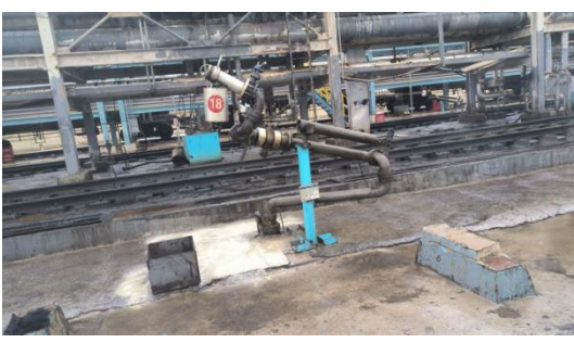
出料口设置防滴漏设施
