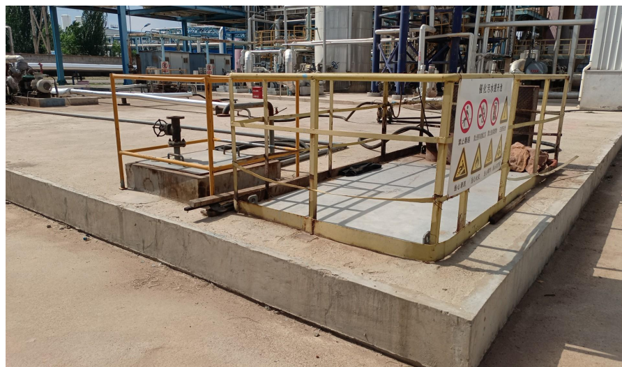
地下半地下池体池体完好
