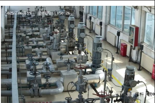
油品部重整加氢罐区重整原料泵房
