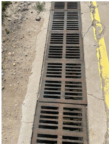
炼油二部氢提纯装置（2#PSA)排水沟
