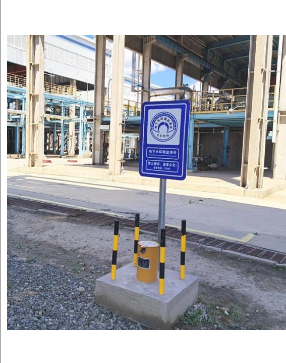
地下水监测井
