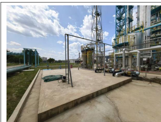
炼油一部丙烷脱氢装置污水提升池
