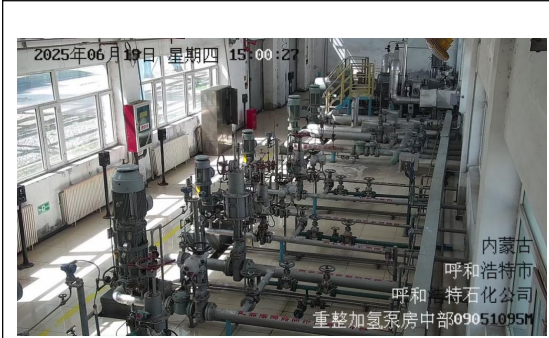
油品部重整加氢罐区重整原料泵房
