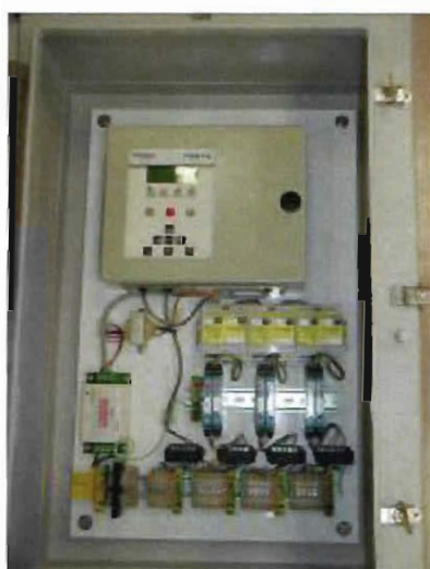
图 12 TTDM-128 控制模块作为主模块, 同时串联 3 个 TTSIM-1 分支模块
