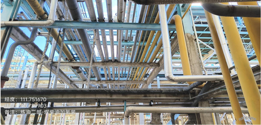
生产装置与生产装置或罐区的地上管道无泄漏痕迹
