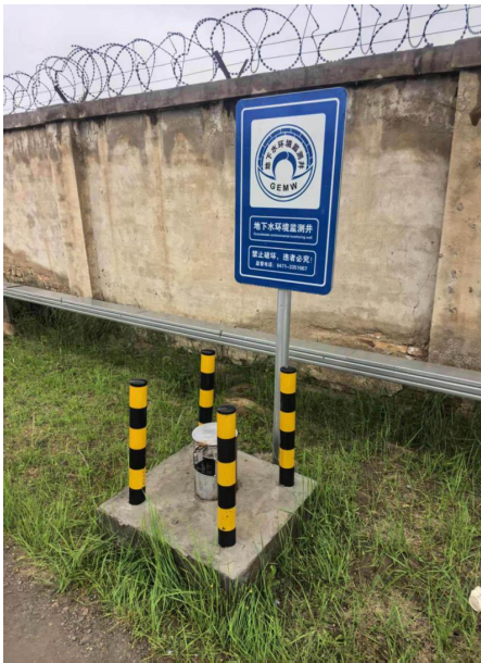
地下水监测井
