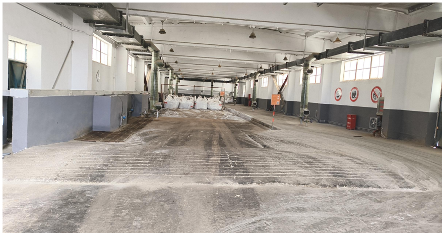
危险废物暂存库内部设施地面硬化
