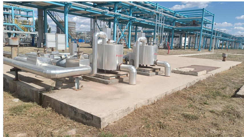
污水提升设施外观完好
