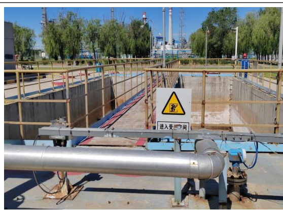
炼油三部聚丙烯污水池
