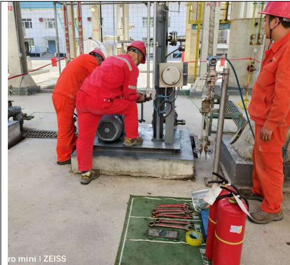
传输泵现场检修过程
