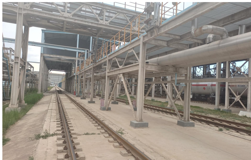
火车装车栈台地面硬化
