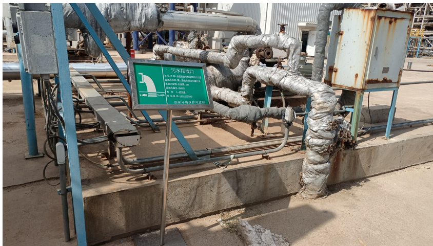
污水排放口硬化完好
