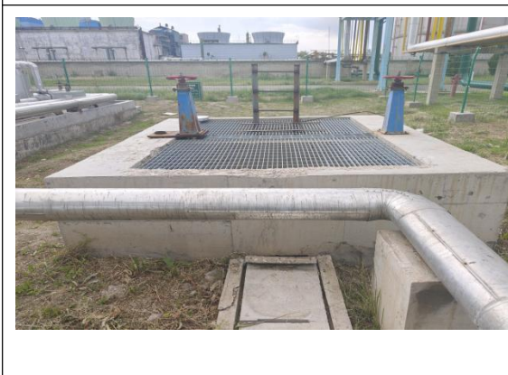
炼油三部硫磺回收装置含油污水初期 雨水集水池
