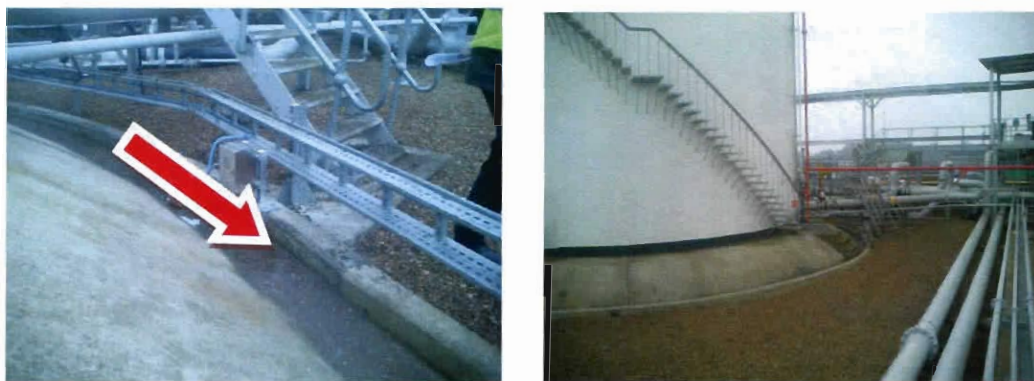
图 7 地面储罐周围混凝土基础上安装 TT-FFS 快速测油棒实例（英国，邦斯菲尔德）
