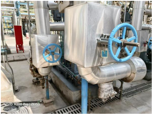
传输泵进料端控制阀门
