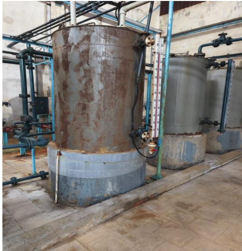
公用工程部再生酸计量箱 0713-V-07
