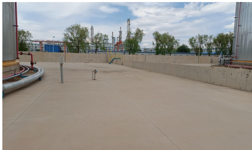
罐区内地面硬化处理
