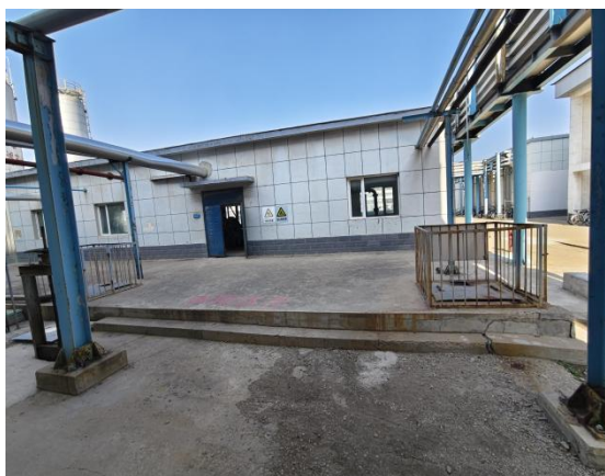
公用工程部污水处理中和池
