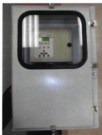
图 12 TTDM-128 控制模块作为主模块, 同时串联 3 个 TTSIM-1 分支模块
