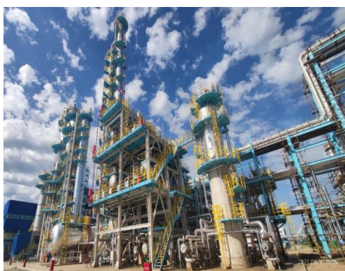
炼油一部丙烷脱氢装置
