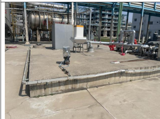
炼油二部柴油加氢改质污水提升池
