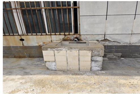
公用工程部除盐水处理站装卸口
