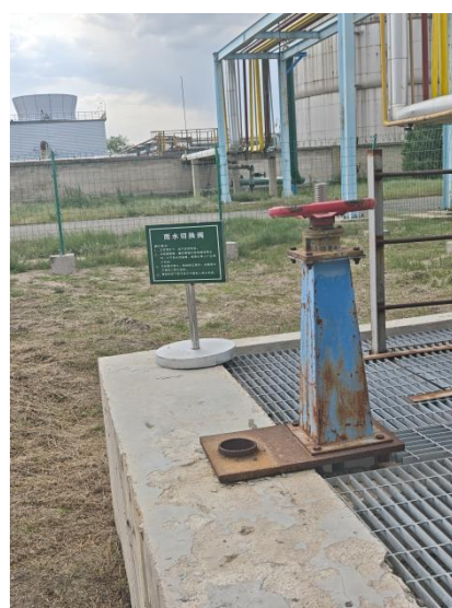
炼油三部硫磺回收污水池雨污切换
