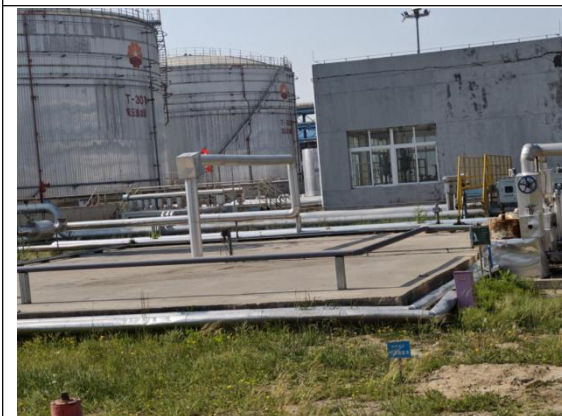
炼油三部硫磺回收装置含油污水初期 雨水集水池
