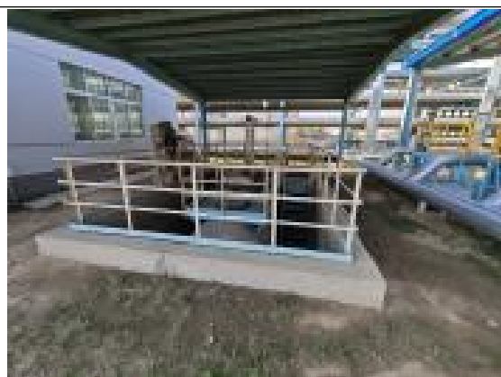
油品部新 3 万立罐区地下污油罐
