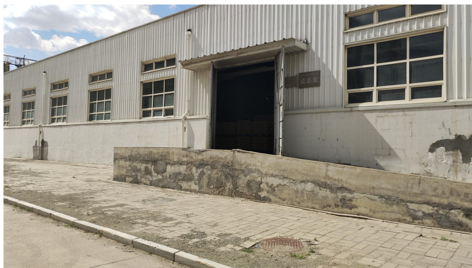
聚甲醛储存库房
