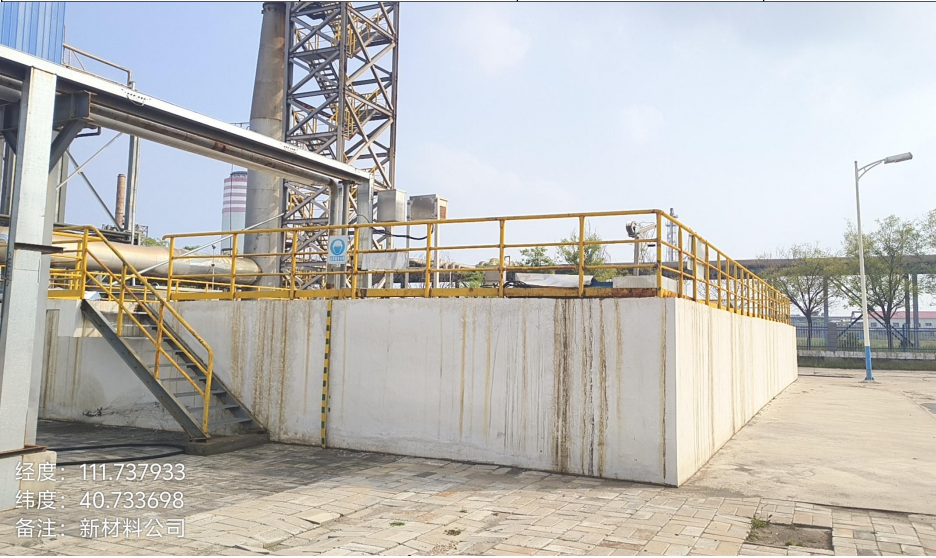
地下半地下池体
