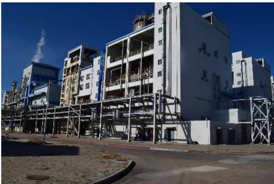
图5.4-1 A 区现场情况照片
