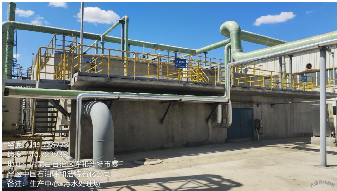
图 2.4-2 G 区现场情况照片
