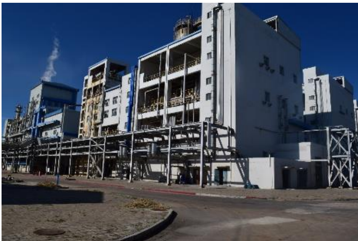
图 2.4-1 A 区现场情况照片
